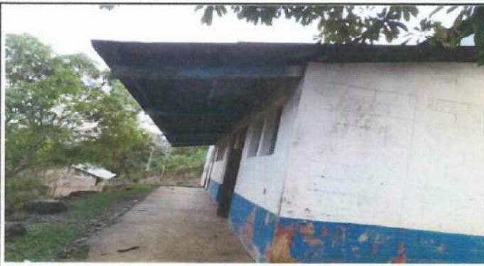
Foto 2: Pintura deteriorada
